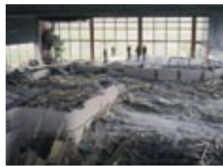
1985 brach die Betonhängecke eines Hallenbades im schweizerischen Uster. Die Aufhängungen der Decke aus nichtrostendem Stahl zeigten rein äußerlich keinerlei Mängel, waren jedoch innerlich teilweise vollkommen durch Spannungsrissskorrosion zerstört.
